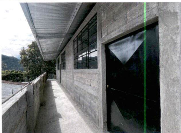
Foto 3: FINALIZACIÓN DE COLOCACIÓN DE PUERTAS Y VENTANAS AL AULA
