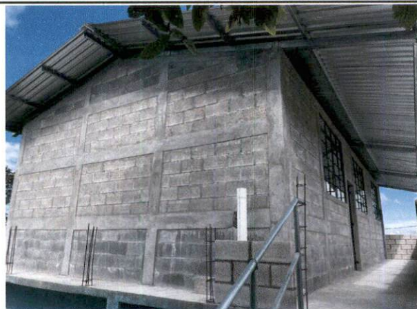
Foto 4: MEJORAMIENTO DE AULA TIPO PÓRTICO CON LÁMINA TROQUELADA CALIBRE 26 FINALIZACIÓN Y MEJORAMIENTO DE LEVANTADO DE MURO.
