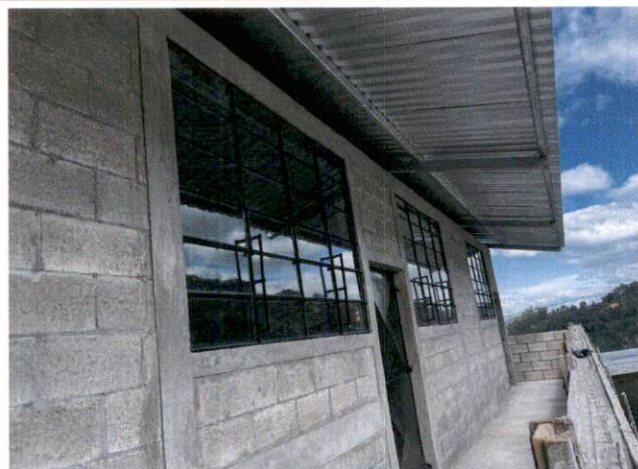
Foto 2: MEJORAMIENTO DE AULA TIPO PÓRTICO CON LÁMINA TROQUELADA CALIBRE 26 Y FINALIZACIÓN Y MEJORAMIENTO DE LEVANTADO DE MURO
